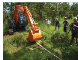
樹木の倒伏耐力についての検証調査
